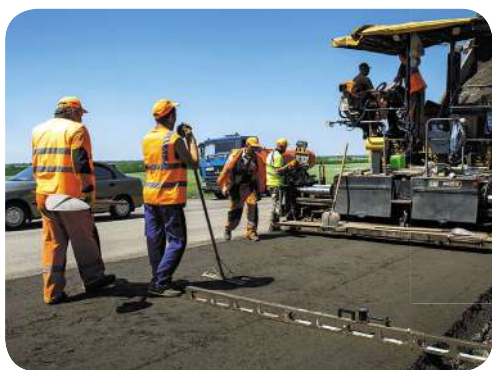
Ремонт дорожнього полотна
