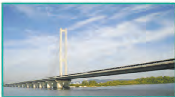
Південний міст. Висота пілону 135 м
